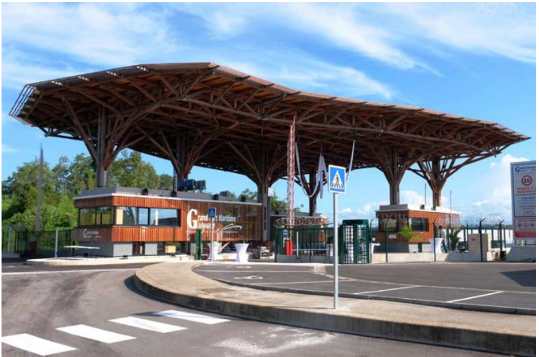
Nouveau complexe entrée-sortie de Dégrad-des-cannes © GPMG
