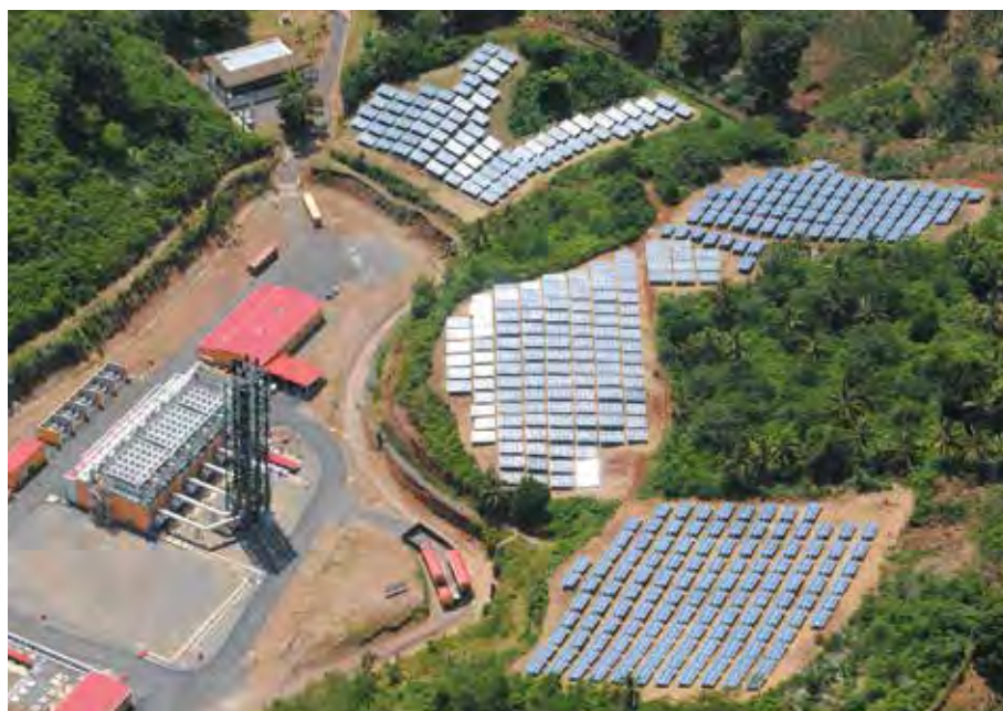
Mayotte. Champ de panneaux solaires à Longoni. © Electricité de Mayotte - EDM
