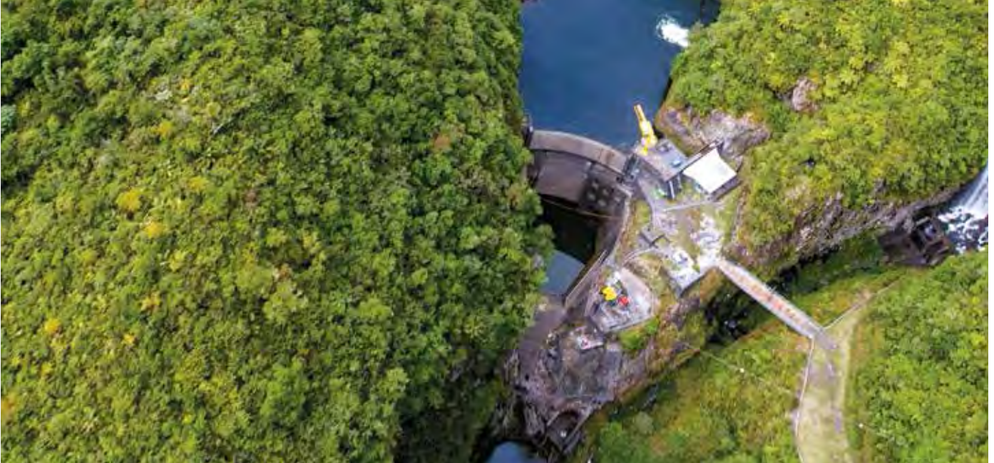
La Réunion. Barrage hydroélectrique Takamaka. © Gaël Sartre - EDF La Réunion
