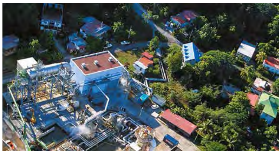
Guadeloupe. Vue aérienne de la centrale géothermique de Bouillante. © BRGM
