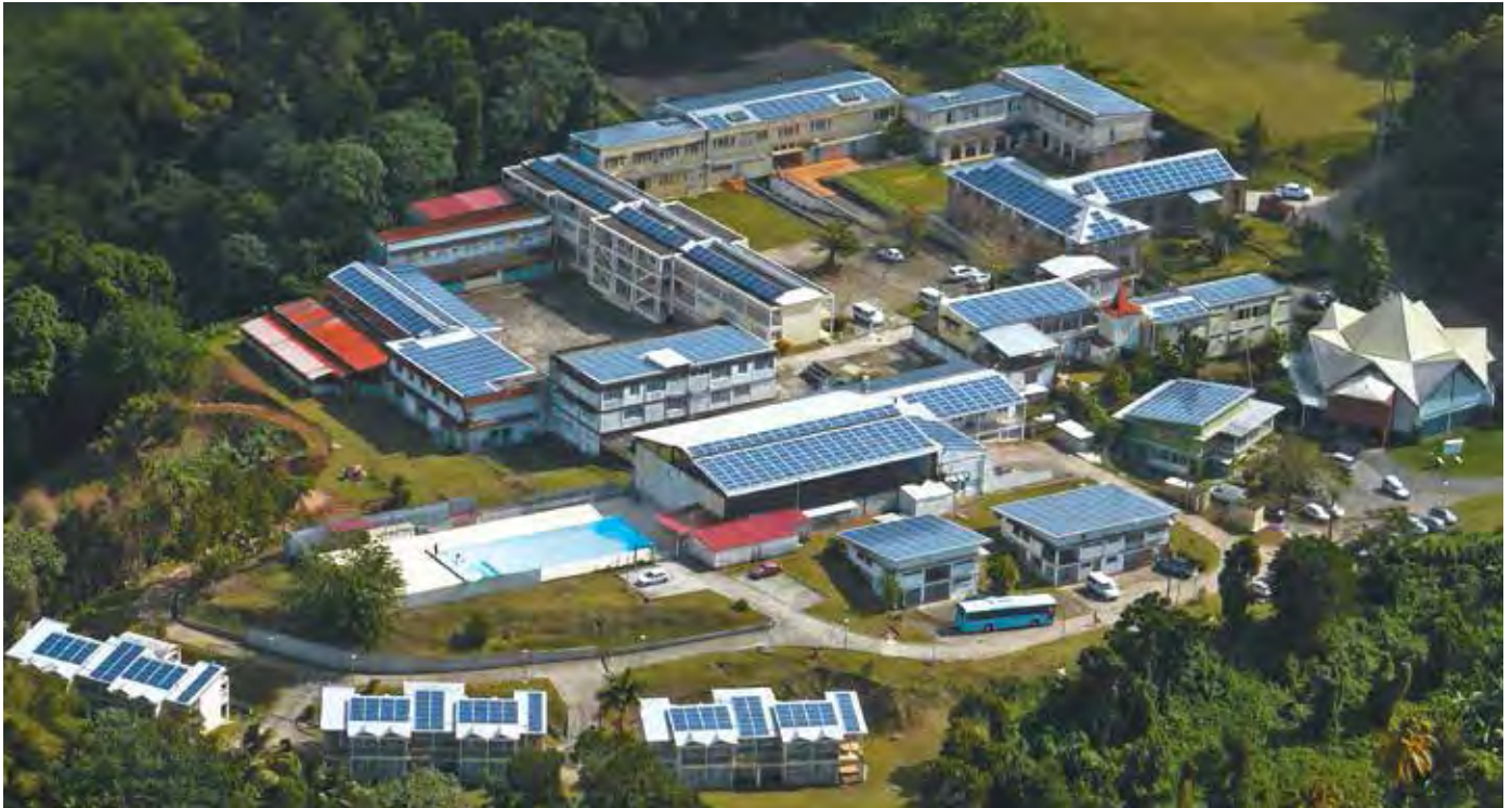
Martinique. Centrale photovoltaïque de l'Espérance. © Patronage Saint-Louis
