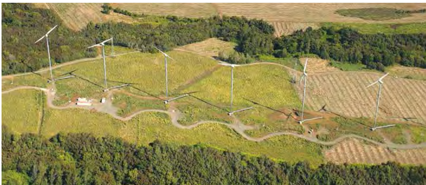
La Réunion. Vue du ciel du parc éolien de Sainte-Suzanne. © Aéro watt
