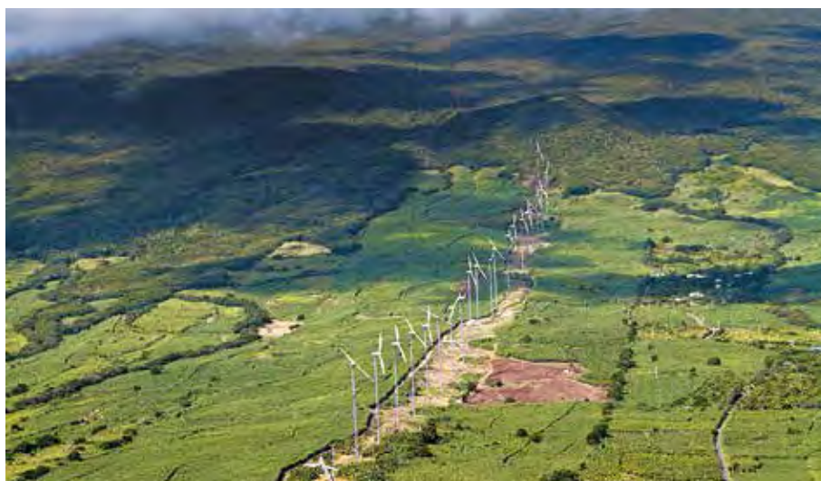
La Réunion. Parc éolien de Sainte-Rose. © Vergnet
