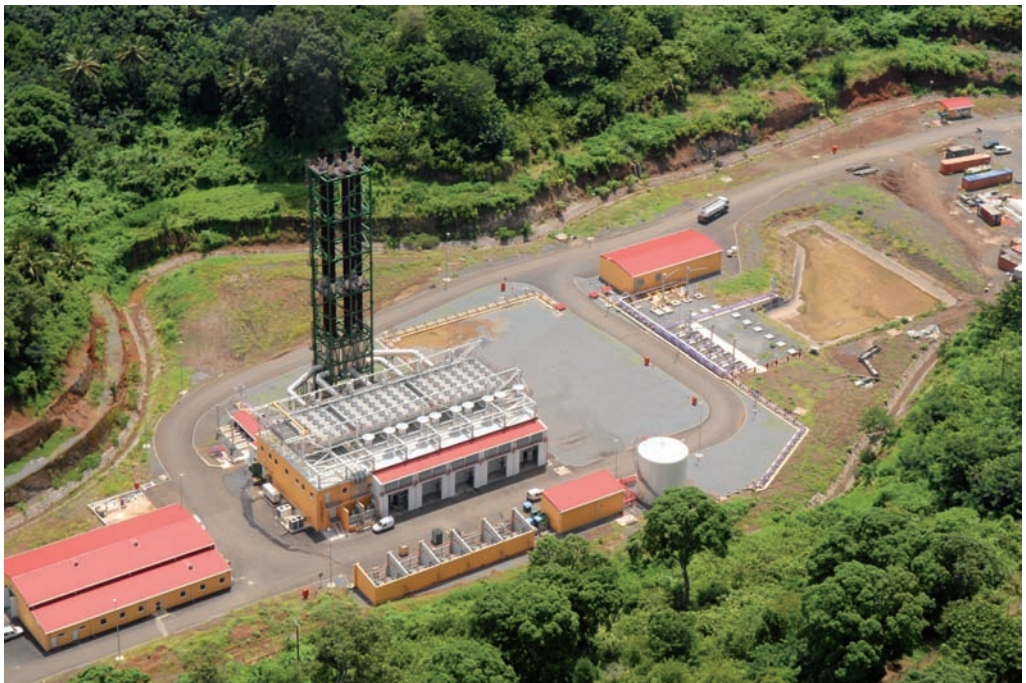
La nouvelle centrale électrique de Longoni (S. Bouvier-Gaz)
