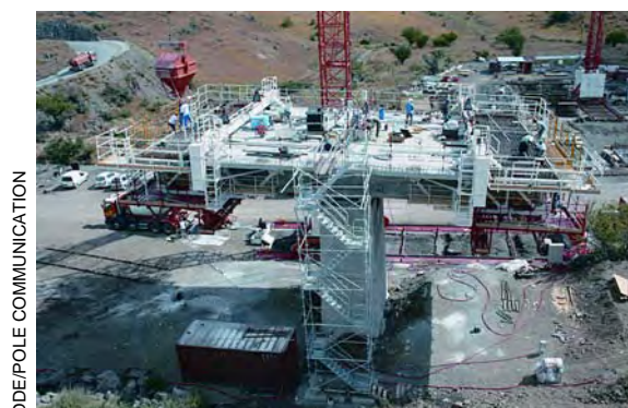
Chantier de la Route des Tamarins - Réunion
