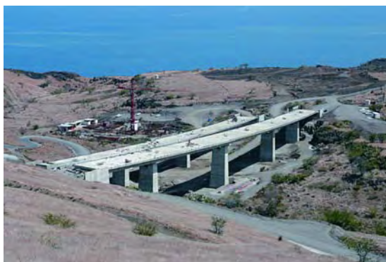
Viaduc de Fleurimont - Route des Tamarins - Réunion
