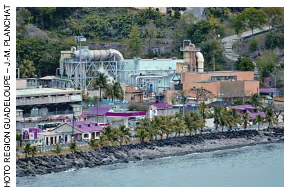
Centrale géothermique de Bouillante- Guadeloupe
