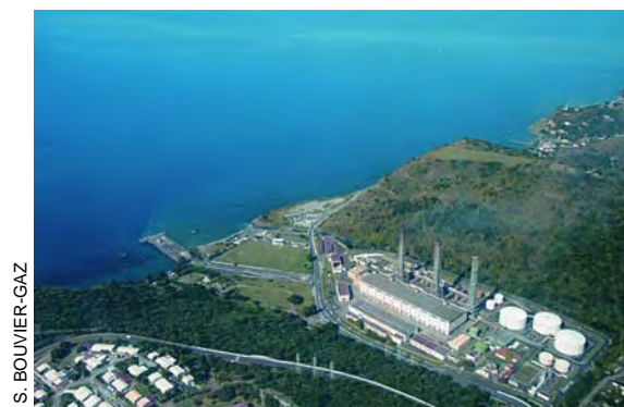
S. BOUVIER-GAZ Centrale EDF de Bellefontaine - Martinique
