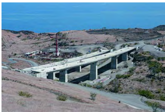
Viaduc de Fleurimont - Route des Tamarins - Réunion
