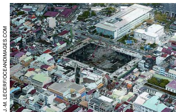
Vue aérienne de la construction du parking Perrinon - Martinique
